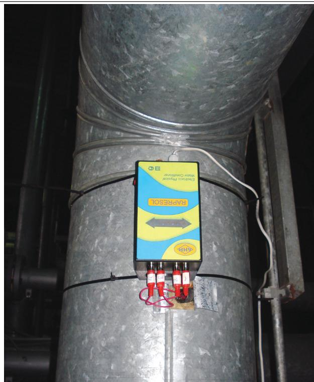
Рис. 2. Пример установки системы электромагнитной защиты трубопровода.
